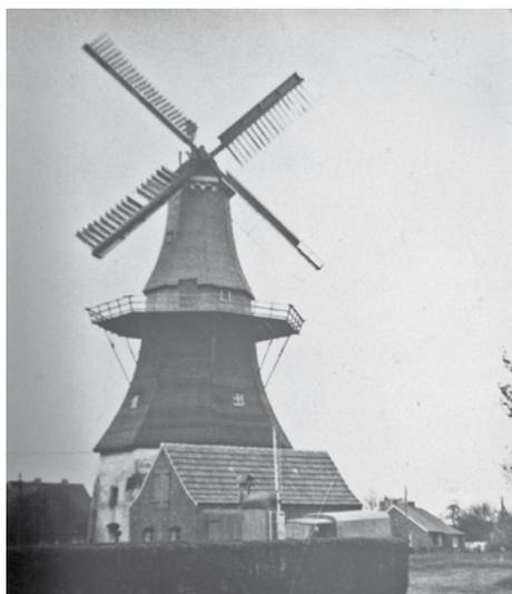
Aus dem ursprünglichen Wallholländer wurde 1958 durch Aufstockung mit einer kleinen Wasserschöpfmühle die einmalige „Doppelmühle“.
