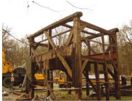
Der Mühlenkasten wurde zunächst am Boden abgesetzt und anschließend in seine Einzelteile zerlegt.
