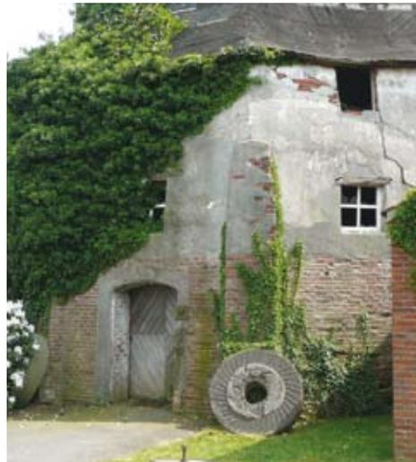
Das Mauerwerk des Mühlenunterbaus (Fundament des ehemaligen Wallholländers) mit dem Eingangsbereich weist bereits deutlich sichtbare Schäden auf.
