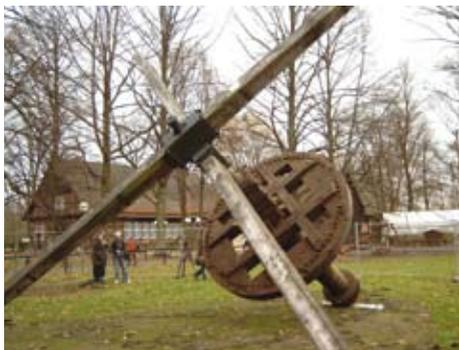
Die ausgebaute Flügelwelle mit Kammsrad und Bruststücken.
