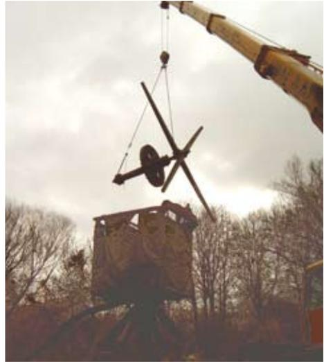
Nachdem zunächst das Dach der Bockwindmühle abgehoben wurde, folgte anschließend die Demontage der Flügelwelle mit Kammrad und Bruststücken. Danach hob der Kran den gesamten Mühlenkasten vom Bock
