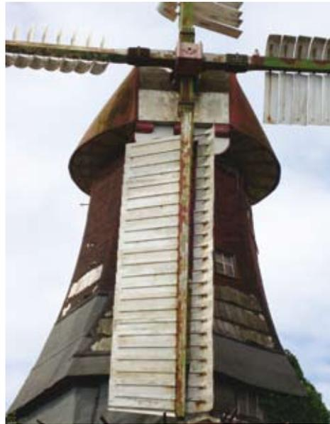
Die vor über 20 Jahren montierten Jalousieflügel sind eine Eigenkonstruktion des früheren Mühlen-Eigentümers Roderich Gramberg. Foto: Ph. Oppermann
