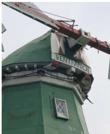
Der Windantrieb soll wieder instand gesetzt werden.
