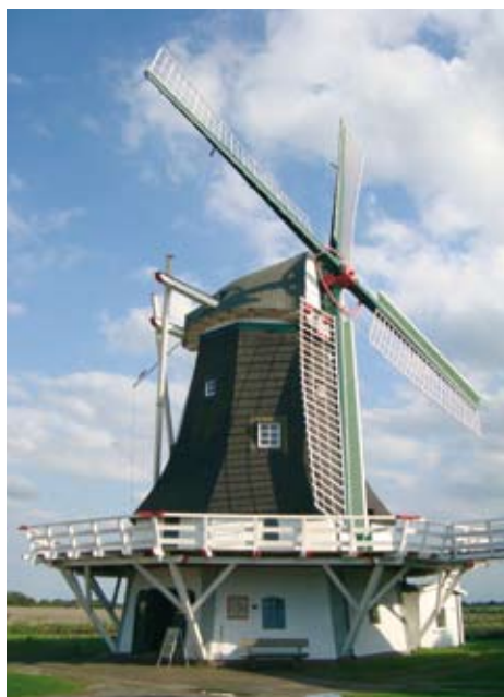
Die Serierner Mühle nach Abschluss der umfangreichen Restaurierungsarbeiten.
