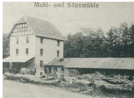
Historische Aufnahme der Blenhorster Mühlen mit der 1908 neu errichteten Getreidemühle (links) und dem langgestreckten Bau der Sägemühle.
