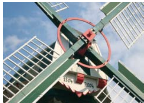
Der Willms'sche Kreuzversteifungsring sorgt für zusätzliche Stabilität des Flügelkreuzes im Achskopf. Er wurde 2006 wieder eingebaut.
