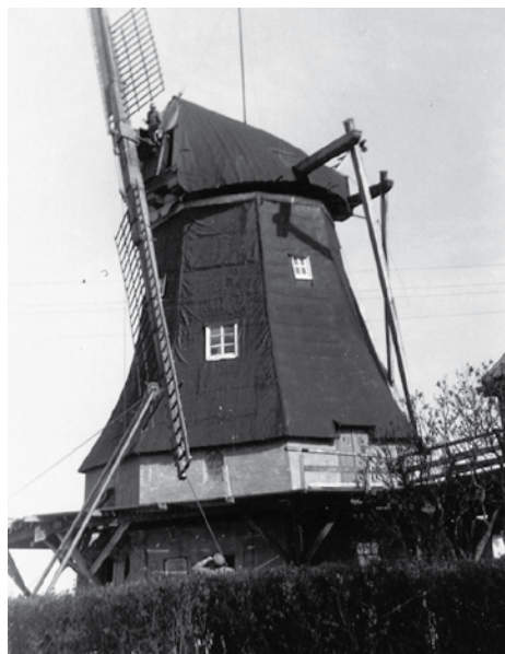
Im Mai 1971 begannen Restaurierungsarbeiten durch Mühlenbauer Hermann Böök. Galerie und Flügel wurden erneuert. Foto: Archiv Mühlenvereinigung
