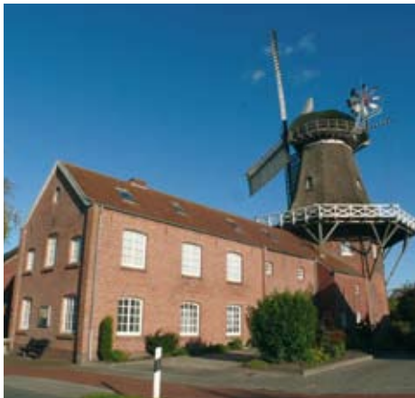
Windmühle und Packhaus in Wiegboldsbur nach der umfassenden Restaurierung. Heute kann wieder mit Windkraft gemahlen werden.
