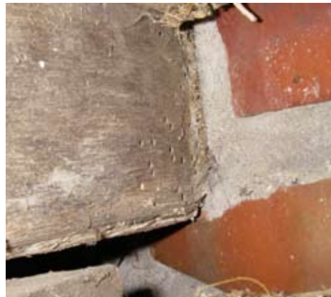
Schädlingsbefall (Gescheckter Nagekäfer) in einem technischen Bauteil einer Wassermühle.
