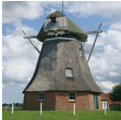
Heute wartet die Mühle in Berdum auf ihre vollständige Instandsetzung. Foto: Ph. Oppermann
