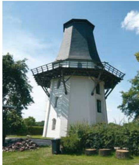
Die Windmühle Sudwalde wurde zu Wohnzwecken umgenutzt. Fotos: W. Neß
