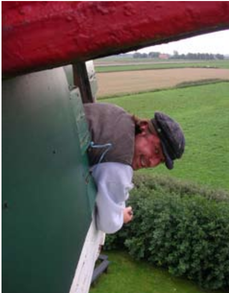
Monumentendienst-Mitarbeiter Michael Zenker bei der Inspektion einer Mühlenkappe.
