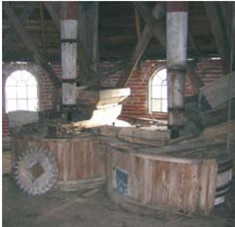
Zwei Windmahlgänge sind noch vorhanden.
