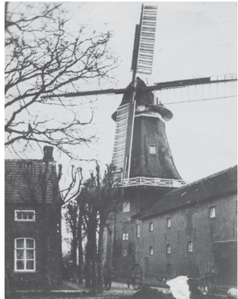
Die Wiegboldsburer Mühle nach Umrüstung auf Windrose und Jalousieflügel 1909. Das Foto entstand vermutlich noch vor dem Ersten Weltkrieg. Foto: E. Groß
