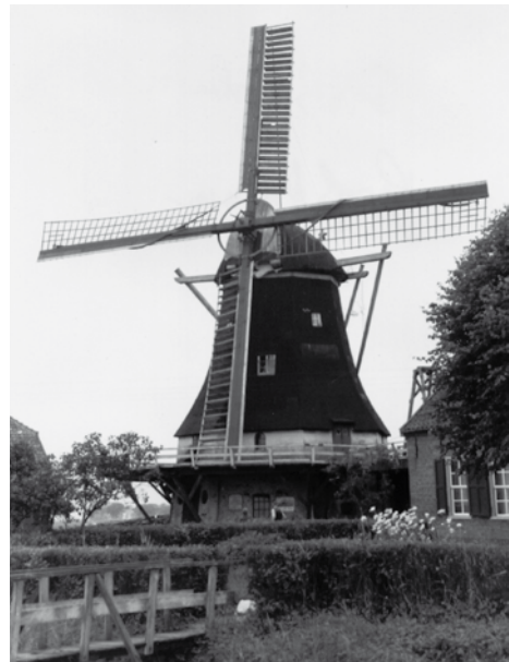
Die Serierner Mühle um 1960 mit einem Paar Segel- und einem Paar Jalousiefügel. Deutlich zu erkennen ist auch der Willms'sche Kreuzversteifungsring.
