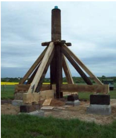
Aufbau des Mühlenkastens unter Verwendung noch brauchbarer und Hinzuziehung neuer Bauteile.
