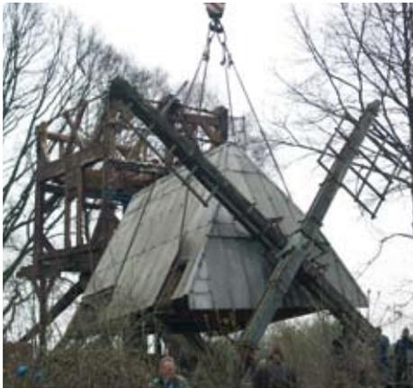
Das Dach mit Flügelwelle und Resten der beiden Kammräder wird von der Mühle gehoben, um anschließend restauriert werden zu können.
