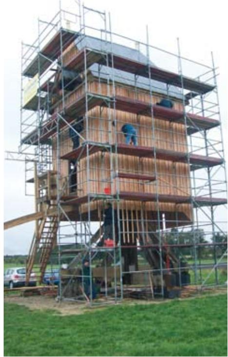
Verkleidung des Mühlenkastens mit Lärchenholz. Der äußere Wiederaufbau ist damit abgeschlossen, das Flügelkreuz folgt 2011.
