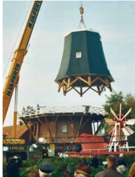
Die Rhauder Mühle erhielt 1996 unter Bauleitung von Richard Kluin einen neuen Achtkant und eine neue Kappe. Foto: Ph. Oppermann
