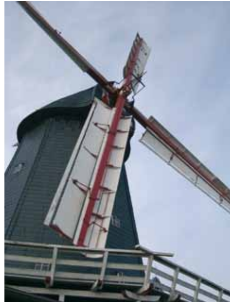
Die Bardowicker Mühle erhielt 1994 eine neue Kappe und ein neues Flügelkreuz nach dem System Ten Have. Fotos: Ph. Oppermann
