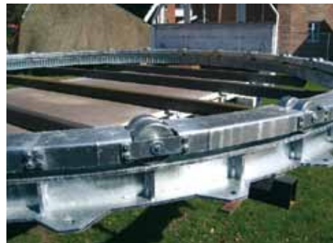
Der eiserne Drehkranz wurde vollständig erneuert.
