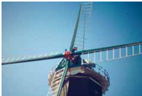
Ein neues Jalousie-Flügelkreuz wird montiert und anschließend mit Busselhecks ausgestattet.
