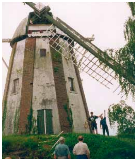
Mit der Demontage des Flügelkreuzes begannen 1998 umfangreiche Restaurierungsarbeiten.
