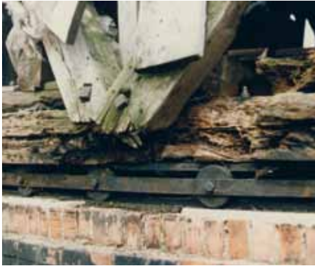
Ringmauer, Rollenkranz und die aus Kiefer gebauten doppelten Ringe unter dem Mühlenkörper, hier im Zustand vor der Restaurierung 1992.
