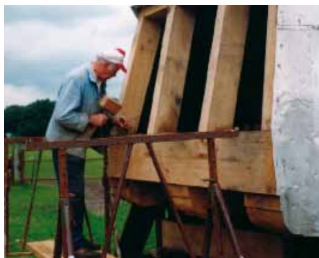
Mühlenbauer Richard Kluin erneuert die Windwand der Mühlenkappe.
