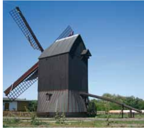
Die Paltockmühle in Asel mit Stert zum Vordrehen.
