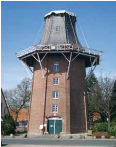
Über mehrere Monate war die Vareler Mühle „kopflös“, Flügel und Kappe waren demontiert und am Boden ab- gelegt worden.
