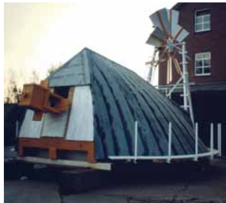
Die Mühlenkappe musste erneut komplett restauriert und in vielen Teilen erneuert werden.
