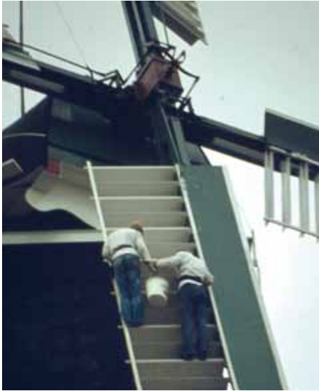
Malerarbeiten an den erneuerten Jalousieflügeln
