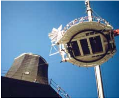
Die restaurierte Kappe wird wieder auf den Achtkant gehoben.
