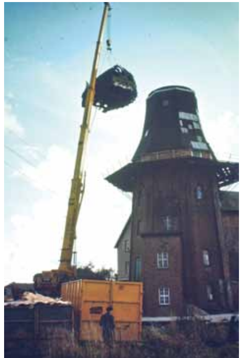
Mit der Erneuerung ihrer Kappe begann 1974 die erste Restaurierung der Bunder Mühle
