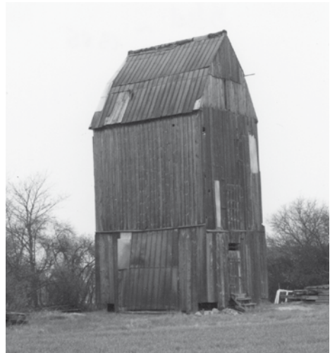
Die Paltrockmühle Bösel ca. 1985. Foto: R. Wassmuth
