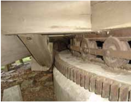
Fundament und Rollenkranz der Baßmühle mit außen-liegendem Zahnkranz und gebogenen Eisenbahnschienen. Foto: E. Tijman
