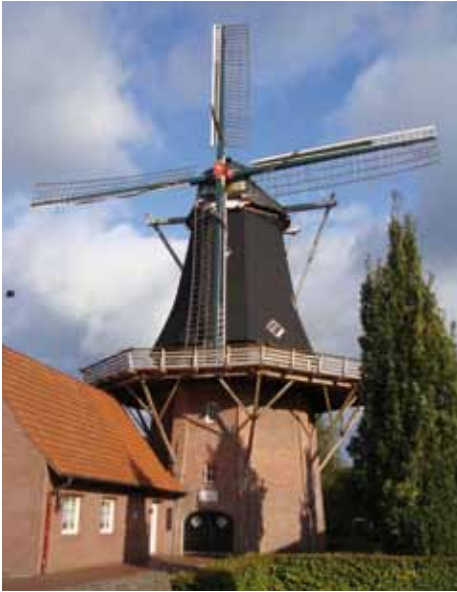
Kreuzmanns Mühle in Werlte wurde unter Mitwirkung der Firma Molema wieder aufgebaut.
