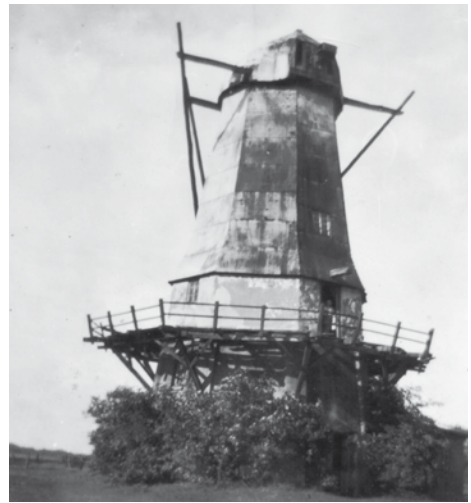
Seit 1943 fehlen die Flügel und der Betrieb lief nur noch mit Motorkraft.
