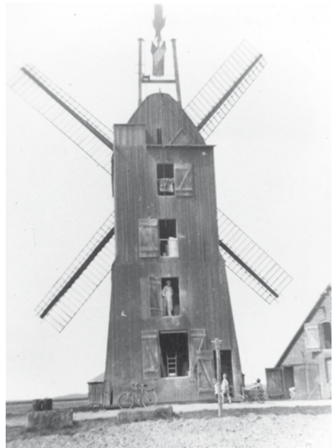
Die Aligser Paltrockmühle der Familie Böttcher, hier noch in Betrieb. Foto: Sammlung E. Tijman
