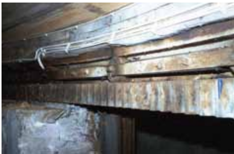
Das Krühwerk der Paltrockmühle Bösel mit innenliegendem Zahnkranz. Foto E. Tijman
