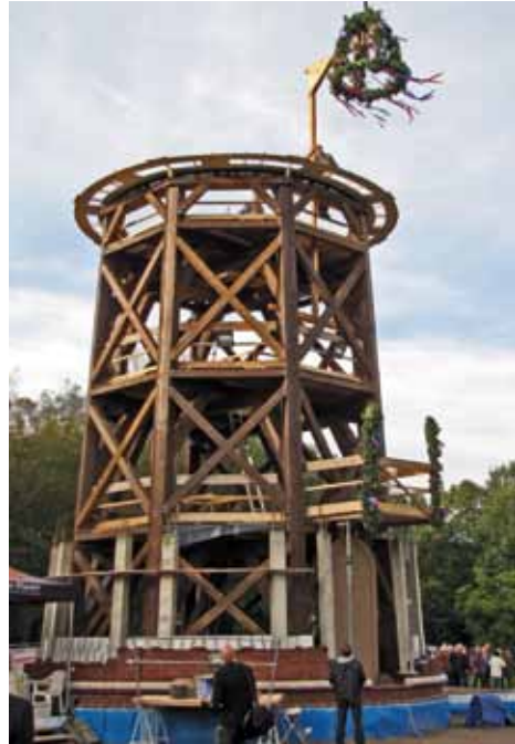
Richtfest am Neubau der Rügenwalder Mühle in Bad Zwischenahn.
