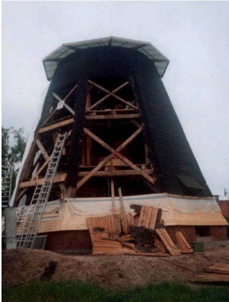
Im Rahmen umfangreicher Restaurierungsarbeiten erhielt der hölzerne Achteck 2004 eine neue Eindeckung.
