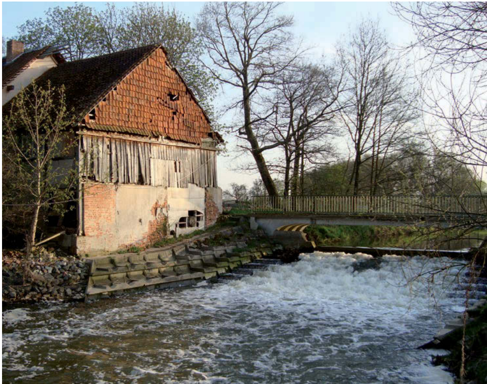
Sieht so die Zukunft für viele historische Wassermühlen aus...? Die Wolfsförder Mühle an der Fuhse bei Dedenhausen (Region Hannover) zeigt deutlich, zu welchen Ergebnissen die Niederlegung von Staustufen an alten Mühlenstandorten führen kann. Hier wurde der Stau bereits vor vielen Jahren entfernt. Foto: Ph. Oppermann
