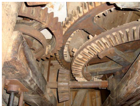
Die Mahlgänge in der Liebenburger Mühle wurden von unten über ein gusseisernes Getriebe mit hölzernen Kämmen angetrieben. Foto: Ph. Oppermann
