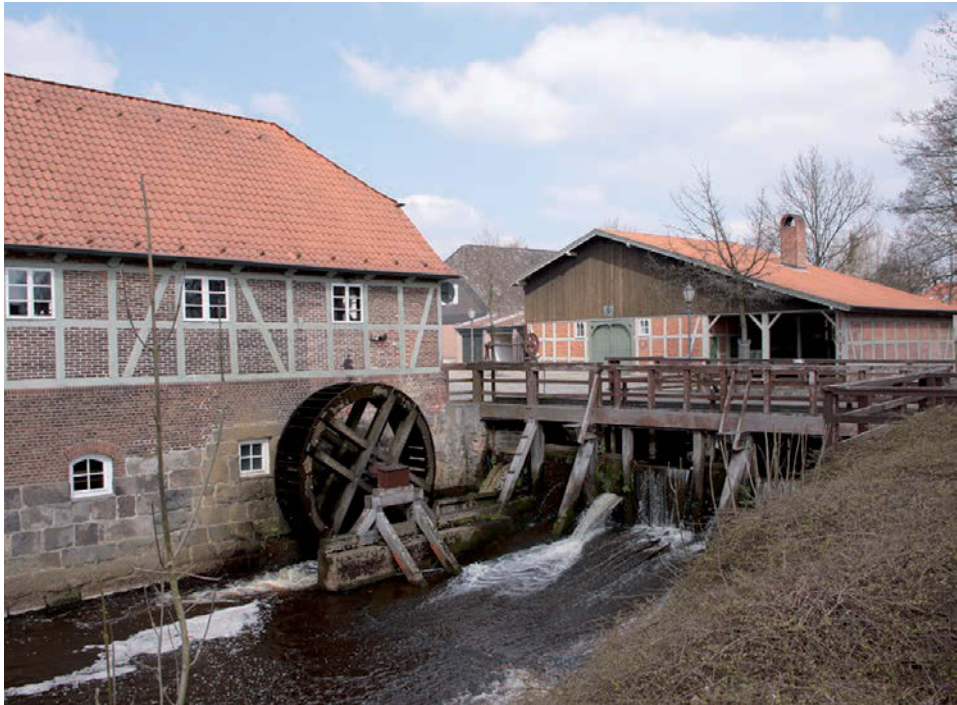
Die Wassermühle in Sittensen mit dem Mühlbach (links) und dem Stauwehr der Oste.
