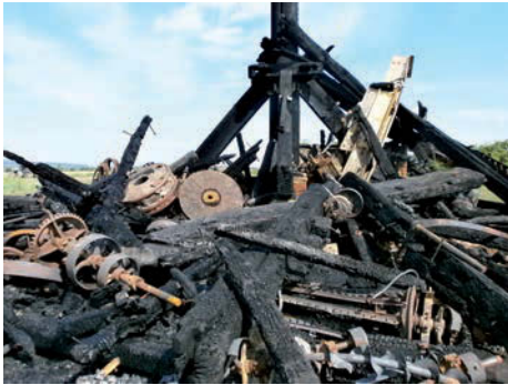
Balkenwerk und Mühlentechnik bilden nur noch ein Trümmerfeld.
