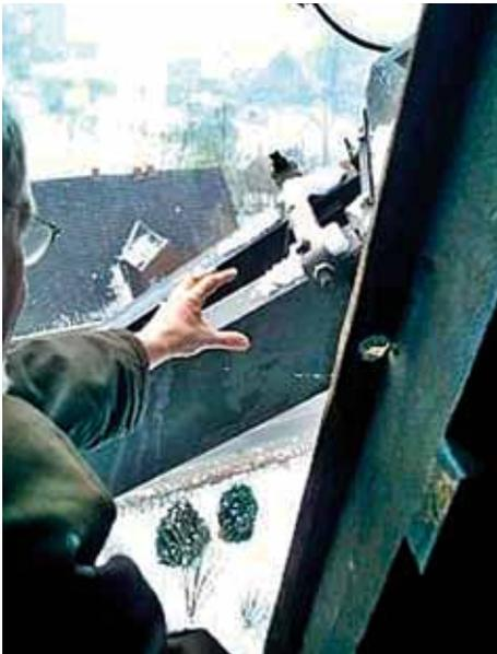
Bild 9, Flügelluke nicht bei laufender Mühle öffnen.
