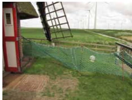
Bild 3, das Netz muss am unteren Rand auch gespannt und befestigt werden. Foto: Rüdiger Heßling
