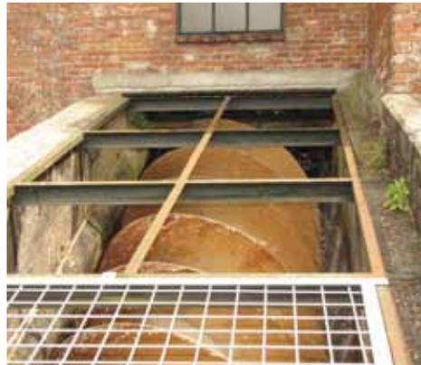
Intakte archimedische Schraube sorgt durch elektrischen Antrieb für die Entwässerung.
