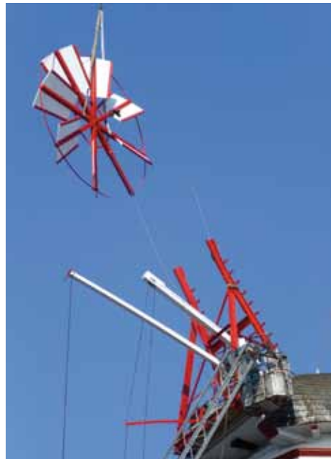
Montage der Windrose. Scans u. Fotos: R. Hebling
