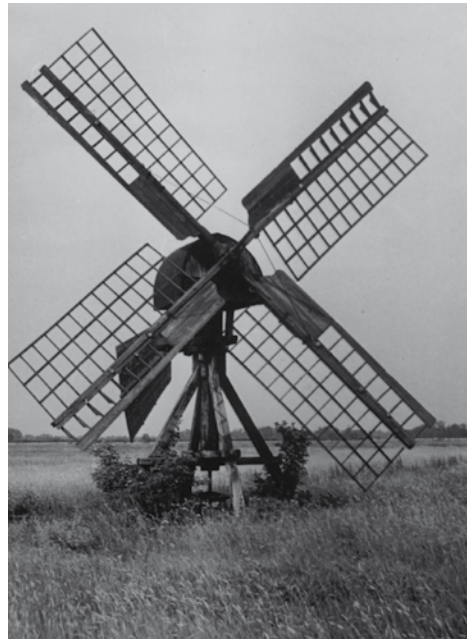
Die Entwässerungsmühle Osterholz-Scharmbeck vor 1935. Zu sehen ist die Versteifungsvorrichtung der Flügel und das eiserne Getriebe für die Schraube.
