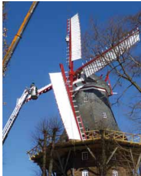
Vierte Flugelrute wird angebaut.
