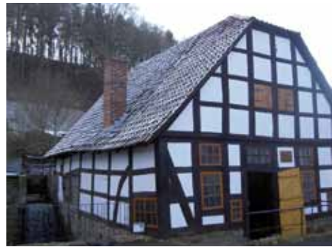
Saniertes Gebäude mit Schacht für zukünftiges Wasserrad.
