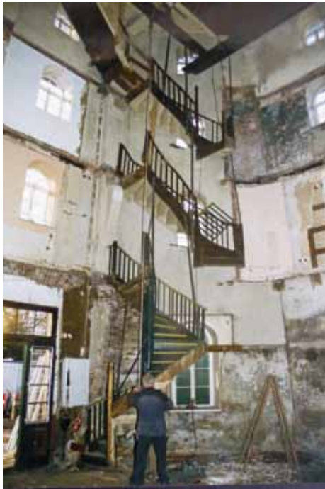
Abriss/Entkernung der ehemaligen Mullerwohnung. Alte Treppe – Auflage des Denkmalschutzes.
