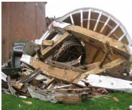
Die komplett zerstörte Kappe.
