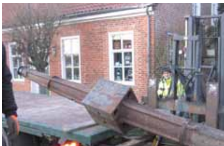
Die noch brauchbaren Teile werden gesichert.
