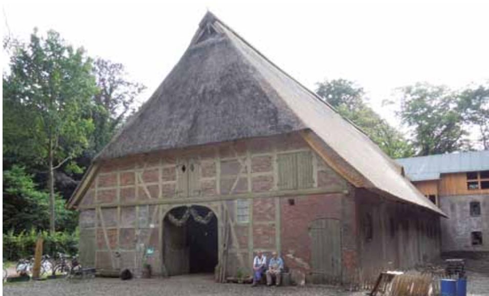
Der Mühlenhof mit neuem Reetdach.
