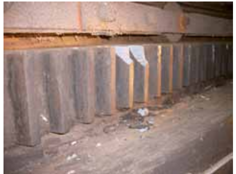
Schaden am Zahnkranz.
