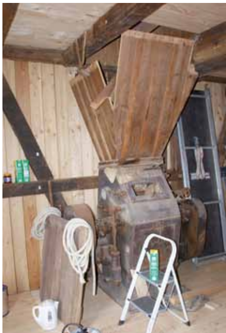
Der alte Walzenstuhl einschließlich Holztrichter aus Roitzsch wurde auch in Schkortitz wieder eingebaut.
