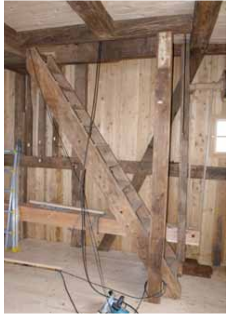
Die Mühle innen, alle Bauteile in guten Zustand wurden wieder verwendet.
