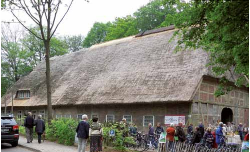
Mühlentag 2013. Am Reetdach wird noch gearbeitet.
