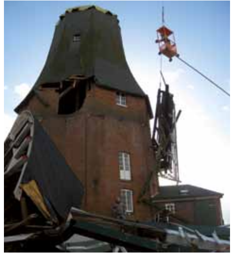
Die Aufräumarbeiten gingen zügig voran.
