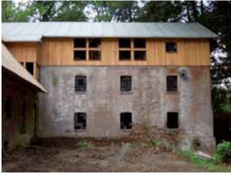
Mühlengebäude von 1893 mit neuem Dach.
