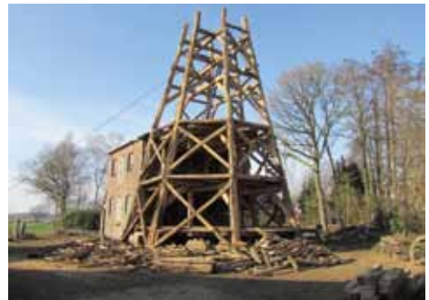
Der komplett freigelegte Achtkant der Mühle, Drahtseile halten die Eckständer in Position. Fotos: F. Butt
