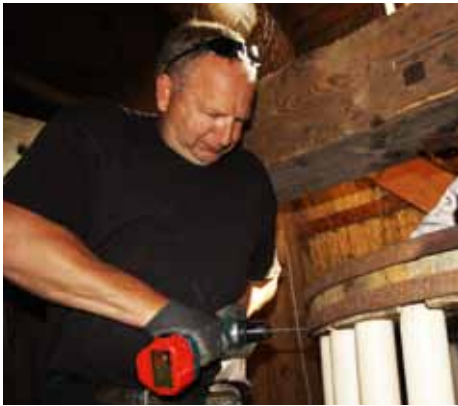
Sicherungsringe am Korbrad positionieren.
