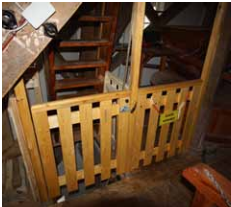
Sicherung der Treppenluken.
