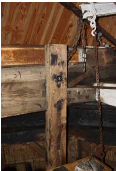
Aufhängungen zwischen Fangstock und Bremsbalken.
