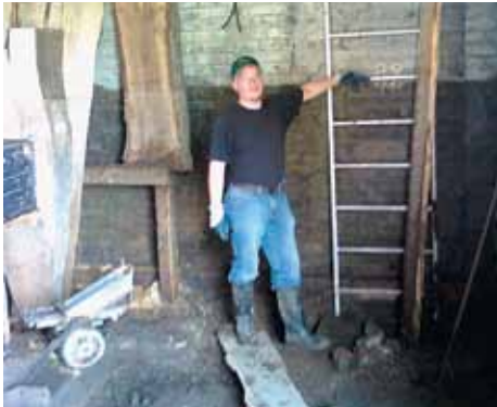
Wasserstand im der Sägehalle nach dem Hochwasser im August 2010.
