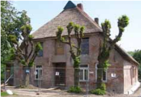
Der Westgiebel des Müllerhauses während des ersten Bauabschnittes am 23. Mai 2012.
