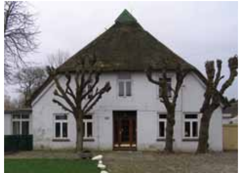
Die Vorderseite des Müllerhauses vor der Sanierung im Januar 2007.
