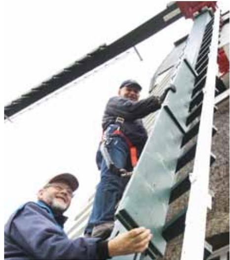
**Bild 2:** Entnehmen der Windbretter.
