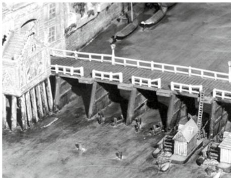
Modell der Wassermühlen = Schiffsmühlen in Bremen, befestigt an der hölzernen Weserbrücke.
