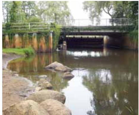
Wassermühle an der Wümmе in Scheeßel (Landkreis Rotenburg/Wümmе). Brücke und Klappenwehr am Wehrarm der Wümmе. Unterhalb der Brücke, im Bild links, an der Spundwand, ist die Fischtreppe zu erkennen, die nach Planungen des NLWKN durch eine funktionsfähige Fischaufstiegsanlage ersetzt werden soll. Fotos: NHB
