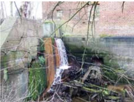
Wassermühle Wrede bei Wietzen, Gefälle und verrottende Antriebswelle des nicht mehr vorhandenen Mühlrads, Landkreis Nienburg.
