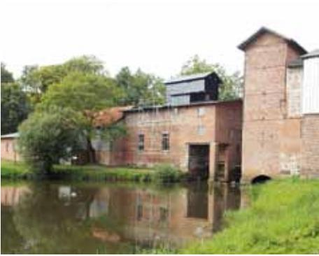
Wassermühle an der Wümmе in Scheeßel (Landkreis Rotenburg/Wümmе). Blick auf das denkmalgeschützte Mühlenensemble vom Unterwasser. Der Auslass der zuletzt aktiven Francis-Turbine befindet sich in dem, im Bild links erscheinenden Gebäudeteil, unter der aufgeständerten Gebäudeecke, der Auslass der zweiten Turbine unter der bogenartigen Öffnung des rechten, turmartig erhöhten Gebäudeteils.
