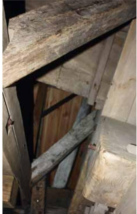
**Bild 7:** Eingelegte Sturmbalkensicherung.
