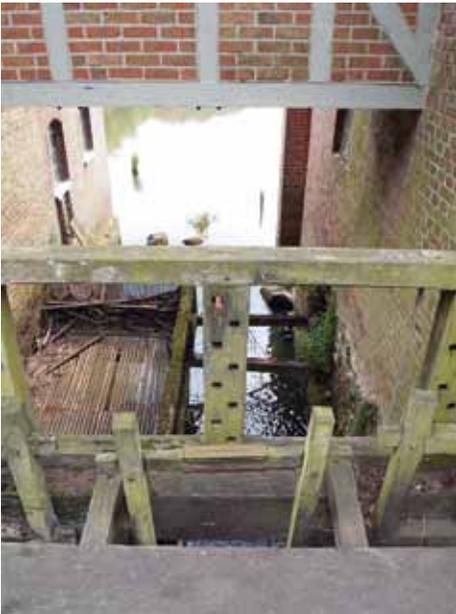
Wassermühle an der Wümmе in Scheeßel. Wehr zwischen den Gebäudeteilen am Mühlarm mit Blick ins Unterwasser; im Bild links der Aalfang, im Vordergrund die Schütztafeln. Nach Ansicht des Mühlenbesitzers sollte eine neue Fischaufstiegsanlage hier hinein gebaut werden.
