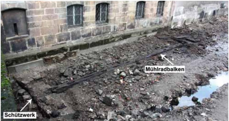
Abb. 4: Blick von der Hasebrücke auf den alten Mühlenstandort. Im Flussbett sind deutlich die hölzernen Reste der Mühlradanlage zu erkennen. Foto: Stadt- und Kreisarchäologie Osnabrück.
