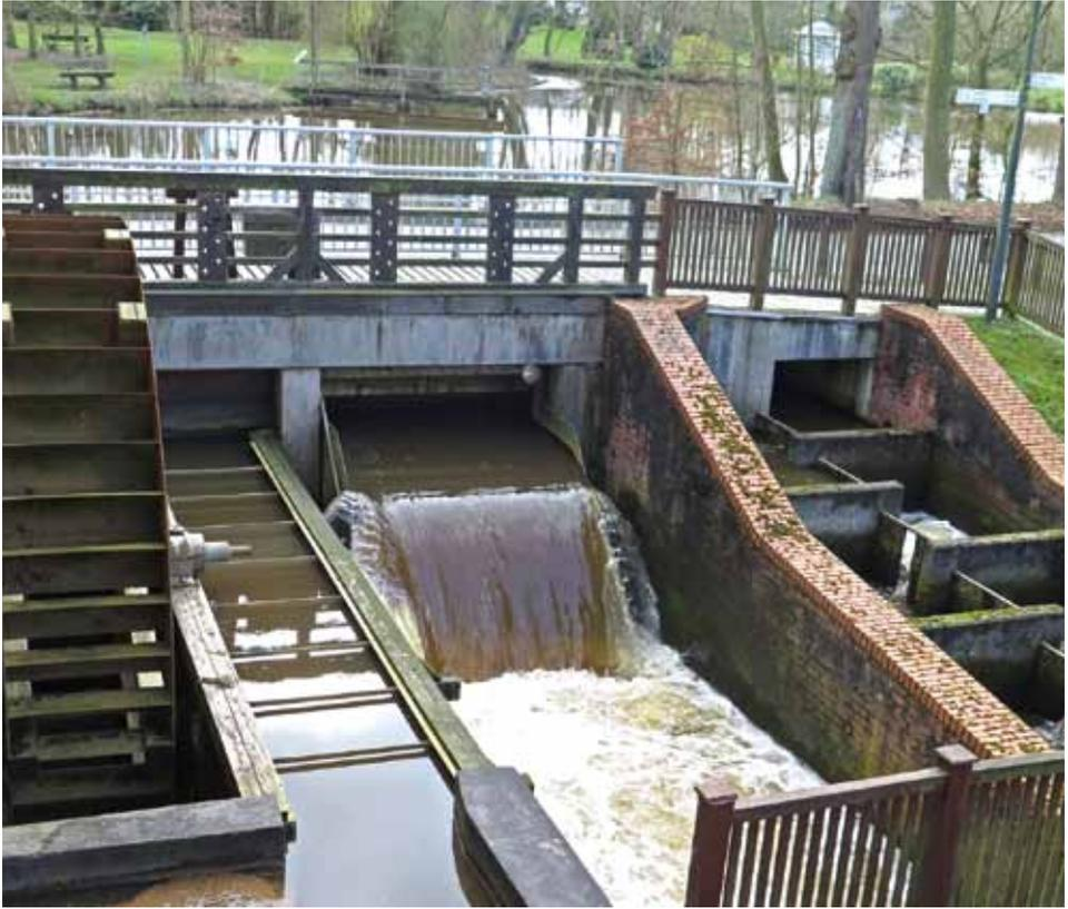
Vier Wege für das Wasser: Wasserrad, Zulauf zur Francis-Turbine, Freiflut mit automat. Wasserstandsregelung und Fischtreppe.
