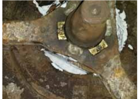
Vergiessen des Halslagers mit Gips. Gut zu sehen der Montagekäfig des vormaligen Kugellagers im Unterstein und die Rotgusskeile des Halslagers.
