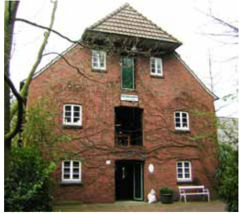
Die Kreyenbrücker Motormühle.
