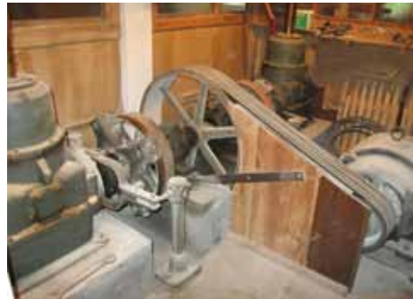
Blick in den Maschinenraum mit dem E-Motor und den beiden Ölbadgetrieben. Fotos: F. Butt
