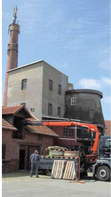
Wenn es erforderlich ist, kommt ein LKW mit Ladekran zum Ausbau und Transport der Mühlenteile zum Einsatz, wie hier dargestellt in Delmenhorst - Adelheide
