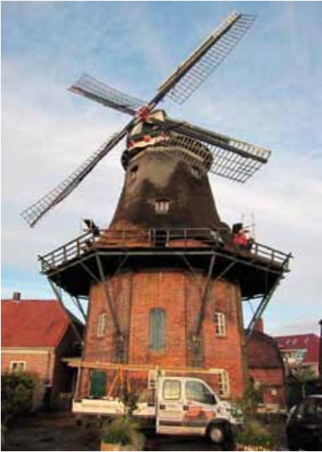
Reparatur des Dachs mit Reet aus Hooksiel.
