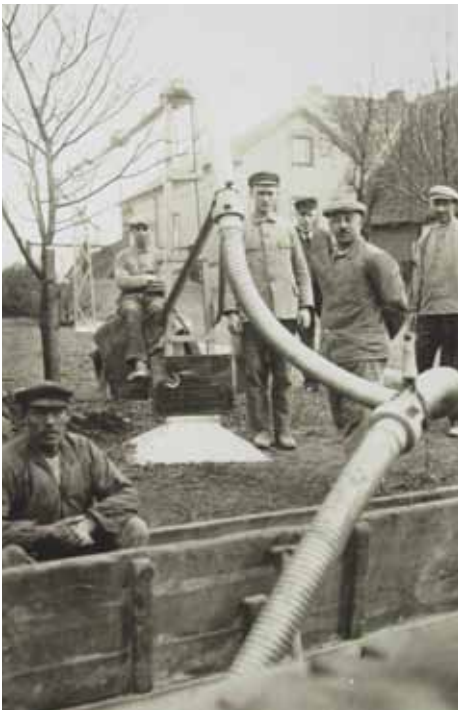
Der Saugheber kurz nach seiner Inbetriebnahme. Deutlich erkennbar die lange Rohrleitung zur Mühle. Archiv: F. Butt
