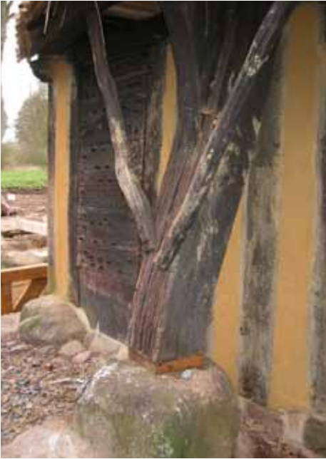
Eingangstür. Ecksäule der Windmühle auf Feldstein als Einzelfundament (auch S.42).
