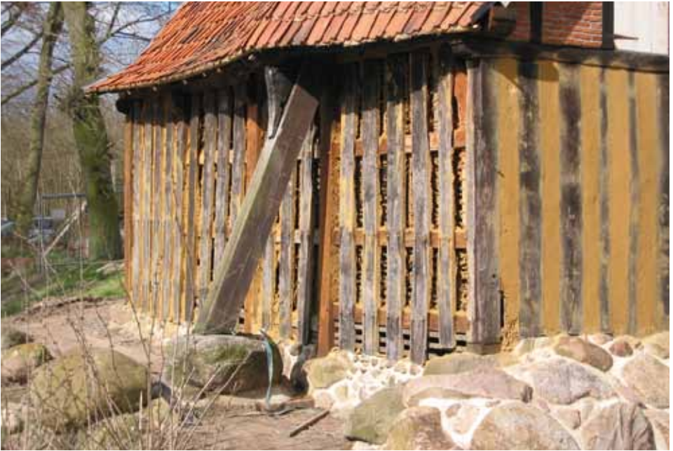
Enges Ständergefüge – ausgefacht mit Staken und Lehmbewurf.
