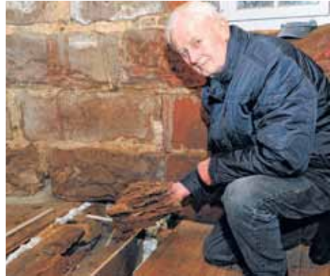
Das befallene Holz läßt sich mit den Händen zerbröseln.
