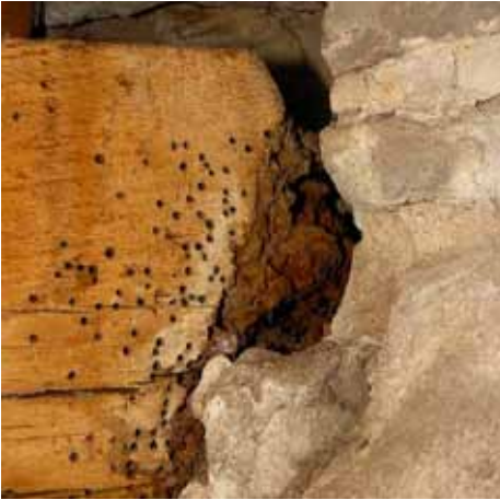
Ein geschädigter Balken vor und nach der Reparatur.
