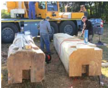
Alter (links) und neuer Hammerbalken lagen kurze Zeit neben der Mühle.
