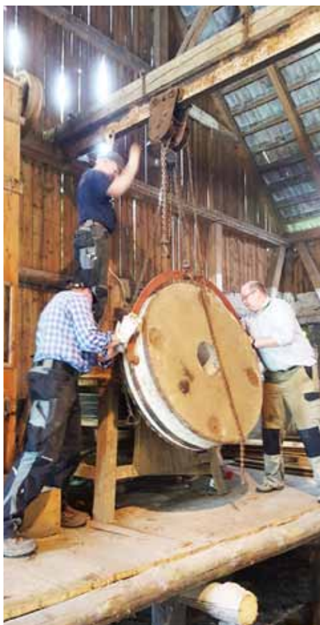
Ausbau des Mahlgangs in Delmenhorst.
