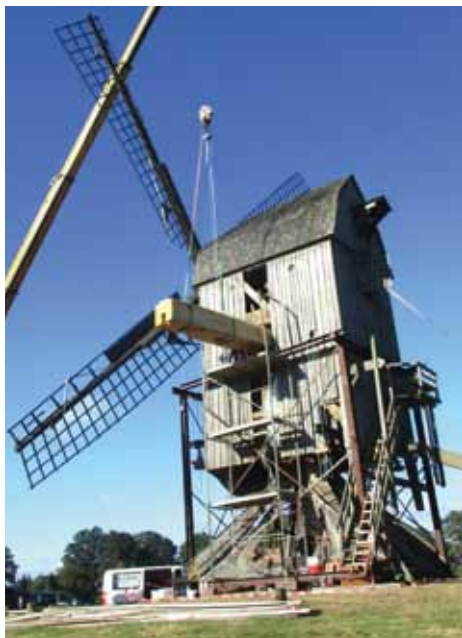
Einheben des neuen Hammerbalkens in die Bockwindmühle am 5. 10. 2016.
