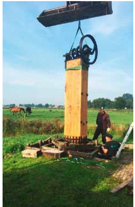
Montage der Doppelkolben-Wasserpumpmühle.
