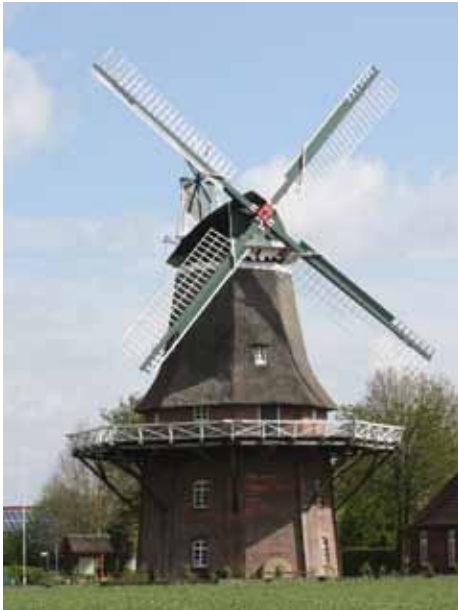
Denkmalgeschützte Windmühle Nenndorf.
