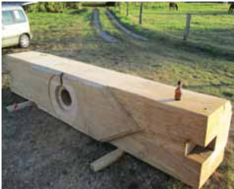
Der neue Hammerbalken liegt fertiggestellt vor der Mühle.
