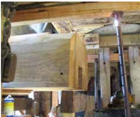
Der neue Hammerbalken wird auf einem speziellen Holzgestell seitwärts in die Mühle gezogen.
