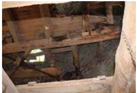
Blick durch die Luke des Sackaufzugs: eindringendes Regenwasser hat dem Gebälk stark zugesetzt, ein Teil der Konstruktion wird lediglich von der großen Transmission gehalten.
