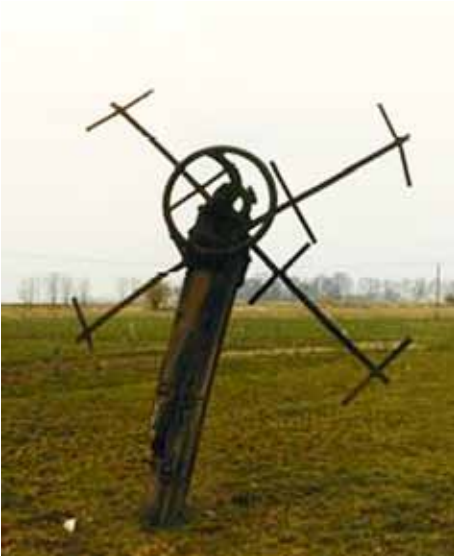
Wirtdumer-Doppelkolbenwasserpumpmühle vor der Restaurierung.
