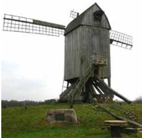
Bockwindmühle Dudensen zwei Tage nach dem Orkan Kyrill am 19. 1. 2007 mit abgebrochenem Flügel.
