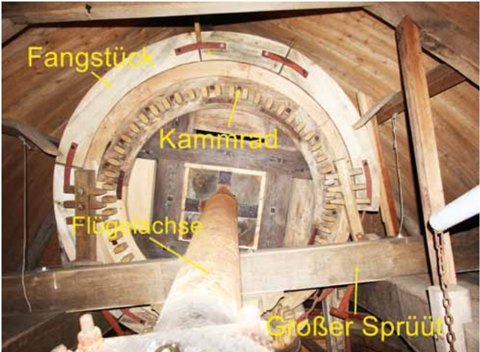
Bild 6: Flügelachse, Kammrad, Fang.
