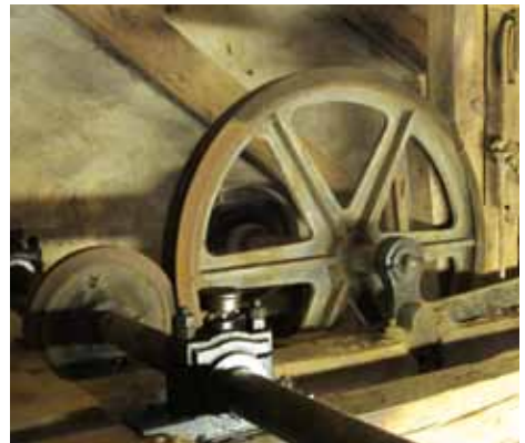
Fahrstuhlantrieb im Schachtkopf.
