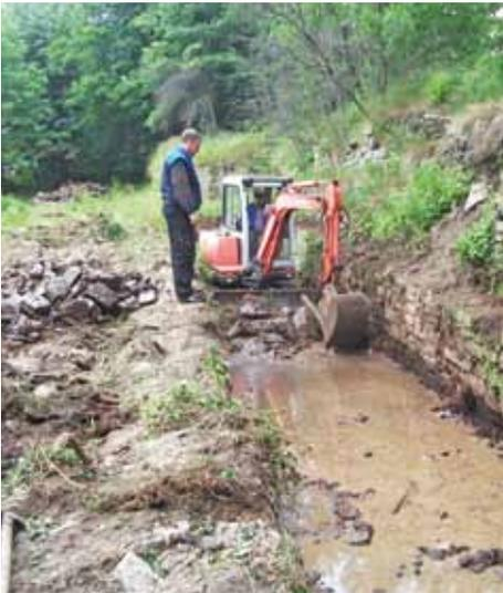
Freilegung des alten Mühlengraben mit Radstube.
