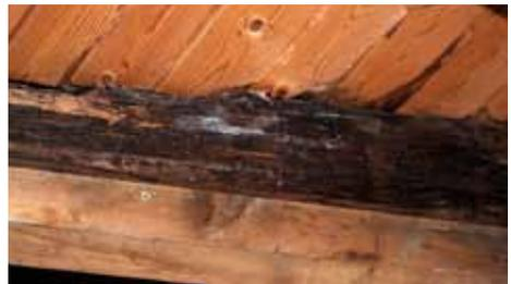
Handlungsbedarf angesagt: Eine von Schimmel befallene und bereits zersetzte Stelle an der Decke des Maschinenbodens. Fotos: C. Jaspersen
