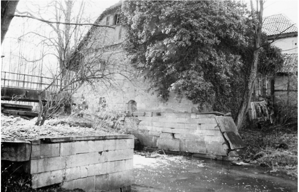
Die Mühle 1990 in beklagenswertem Zustand.
