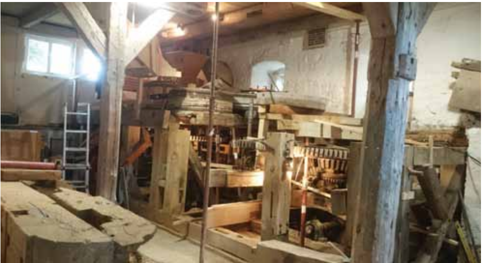
Eindruck von der Baustelle
