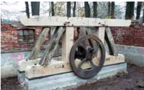
Das Gatter-Unterteil ist wieder eingekrant und auf das sanierte Fundament gesetzt.
