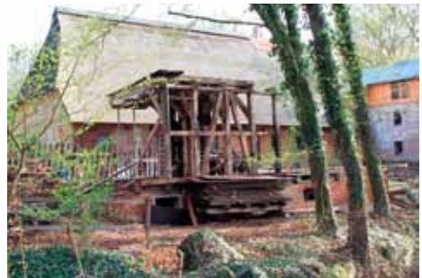
Das Sägehaus ist abgetragen, die Gattersäge steht frei.
