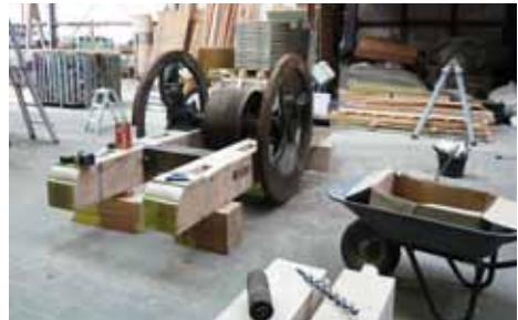
In der Zimmerei: Restaurierung des Gatterrahmens, der Großteil der Holzkonstruktion wird erhalten.
