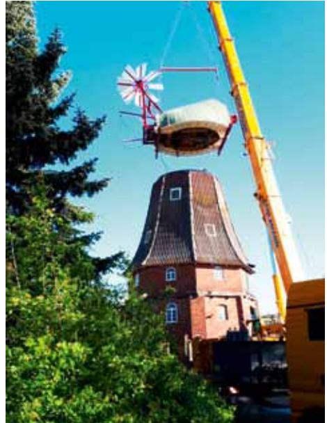
Aufsetzen der Mühlenkappe, im April 2020.
