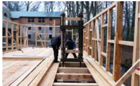
Wiederaufbau der Sägerei nach vorhandenen Originalplänen, die Gattersäge steht.
