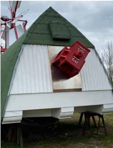
Das Wasserhaus der Kappe kurz vor dem Aufsetzen. Der gusseiserne Wellkopf wurde 1913 gegossen.
