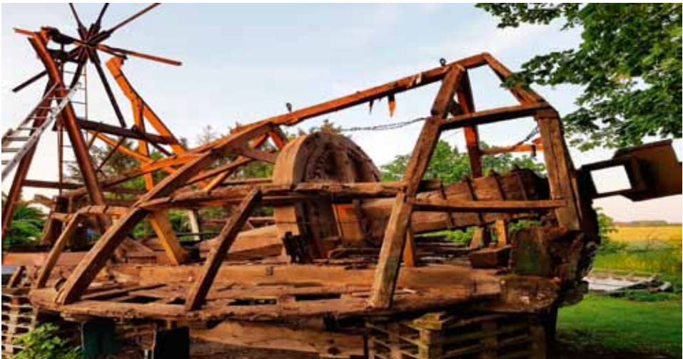
Das Gerippe der Kappe vor dem Abbau, im Mai 2019.
