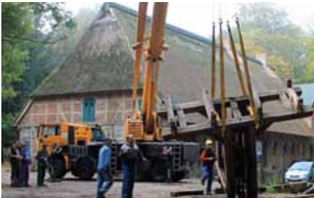
Auskrantung der Gattersäge mit Teleskopkran und Transport in die Zimmerei.
