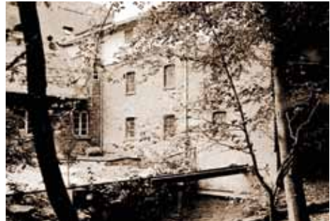
Anfang der 1960-er Jahre. Haupthaus und Mühle, vorn die 33 m-Welle vom Wasserrad zur Sägerei.
