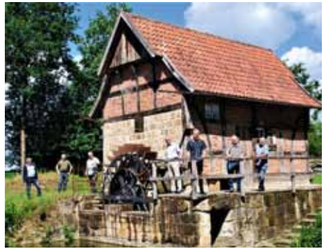
Wassermühle Hofanlage Pöpping in Rheine / Elte, Funktionskontrolle unterschächtiges Wasserrad.
