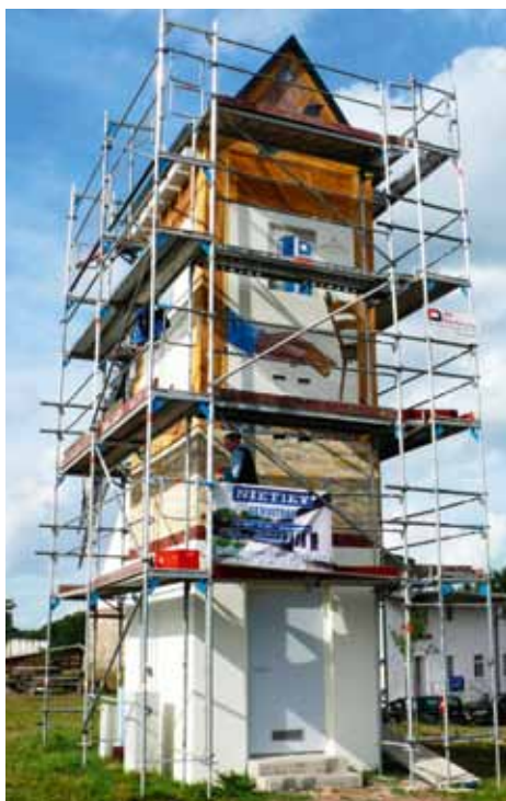
Eine „Stele der Biodiversität“ ist aus dem ehemaligen Trafogebäude geworden.
