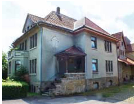
Ansicht von der Straße aus.
