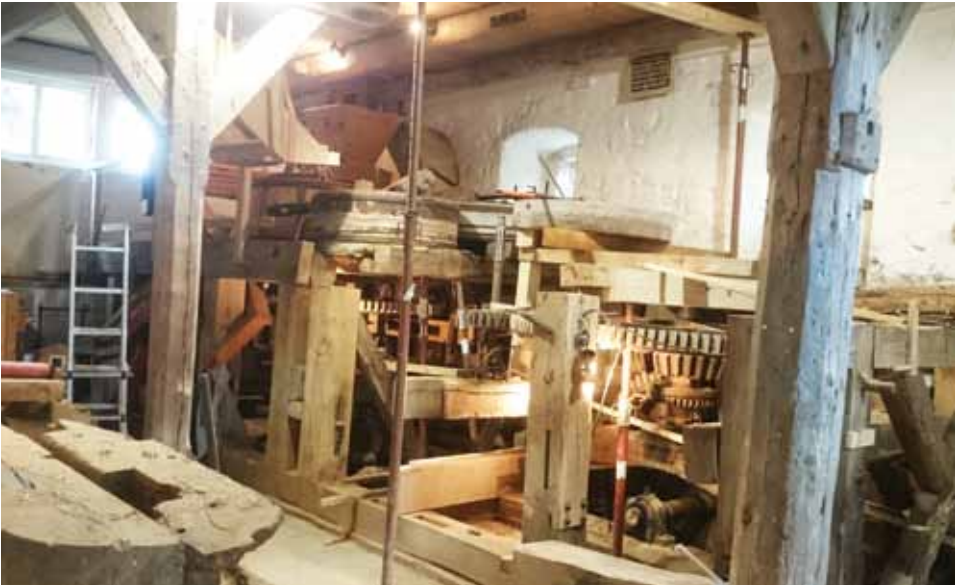
Eindruck von der Baustelle.
