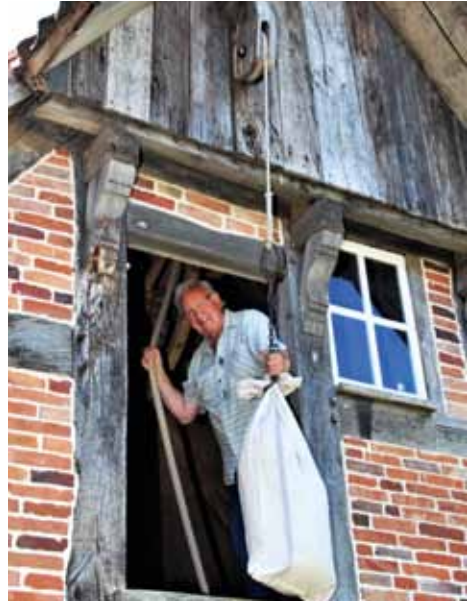
Das Gaffelrad ermöglicht ein nahezu müheloses Heben von Lasten in Form von Säcken.
