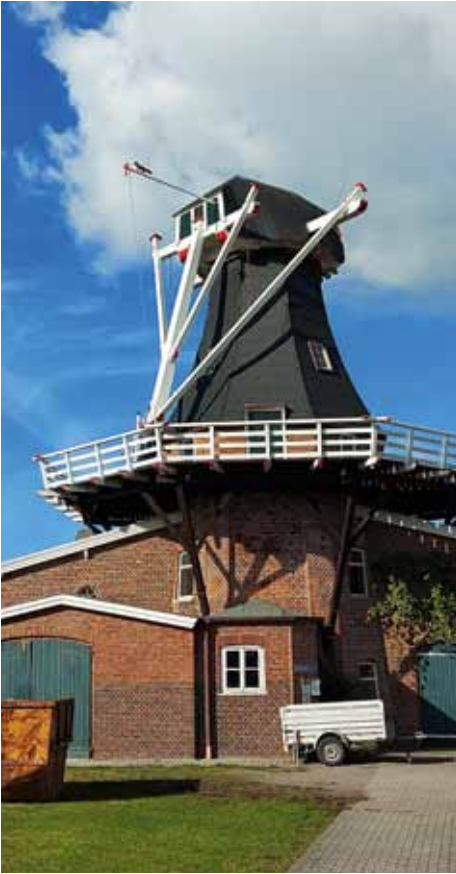
Die Mühle mit restaurierter Kappe und Steert zum Drehen der Kappe. Foto: G. Scheweling
