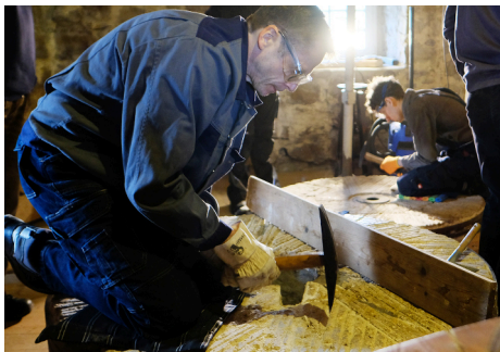
Die Mahlsteine der Windmühle in Vlotho/Exter werden von Silvio (links) und Gerrit (rechts) mit der Bille bearbeitet.
